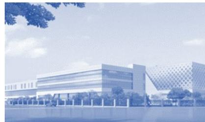
■项目用地面积约 157.7 亩，总投资约 42 亿元，总建筑面积约 12.4 万平方米，拟建设两条偏光片生产线，建设内容包括生产车间、变电站、平置仓库、综合厂房、化学品仓、资源回收厂等。项目建成后，将成为全球单体规模最大的偏光片生产基地。
