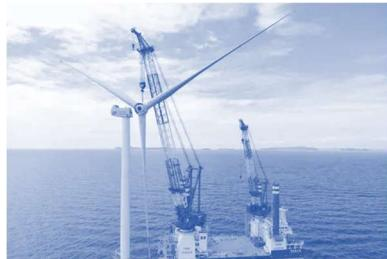
■ 该项目位于辽宁省庄河市石城岛东侧海域，平均水深 30 米，场址中心离岸距离约 35 公里，规划面积 55.8 平方公里，设计装机容量 350 兆瓦，由中国铁建港航局与中国电建华东院承建。整体投运后预计年发电量约 9.6 亿千瓦时，可满足 96 万户家庭年用电需求。与同等规模的火电厂相比，每年可节约标煤 30 万吨，减少污染物排放 66 万吨（大连市政府网站）。
