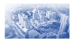
■总投资额约 15 亿元,总用地面积约 4.03 万平方米,包含三个地块。项目以"工业上楼"为主导,可新增超 16 万平方米的 5.0 产业空间及基础配套。作为三溪科创小镇启动区的重要组成部分,格创•智造项目进一步升级了厂房规格,局部柱网设置为9×12 米,首层部分荷载达 2T、层高 8 米,2-3 层层高 6-7 米,4 层以上层高超过 4.5 米,可以满足大部分企业的生产空间需求(珠海市政府网站)。
