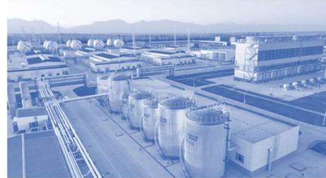
■该项目由中国石化新星公司负责实施，是国内首次规模化利用光伏发电直接制绿氢的项目，利用新疆地区丰富的太阳能资源发电直接制绿氢，电解水制氢能力 2 万吨/年、储氢能力 21 万标立方、输氢能力 2.8 万标立方每小时（国资委网站）。
