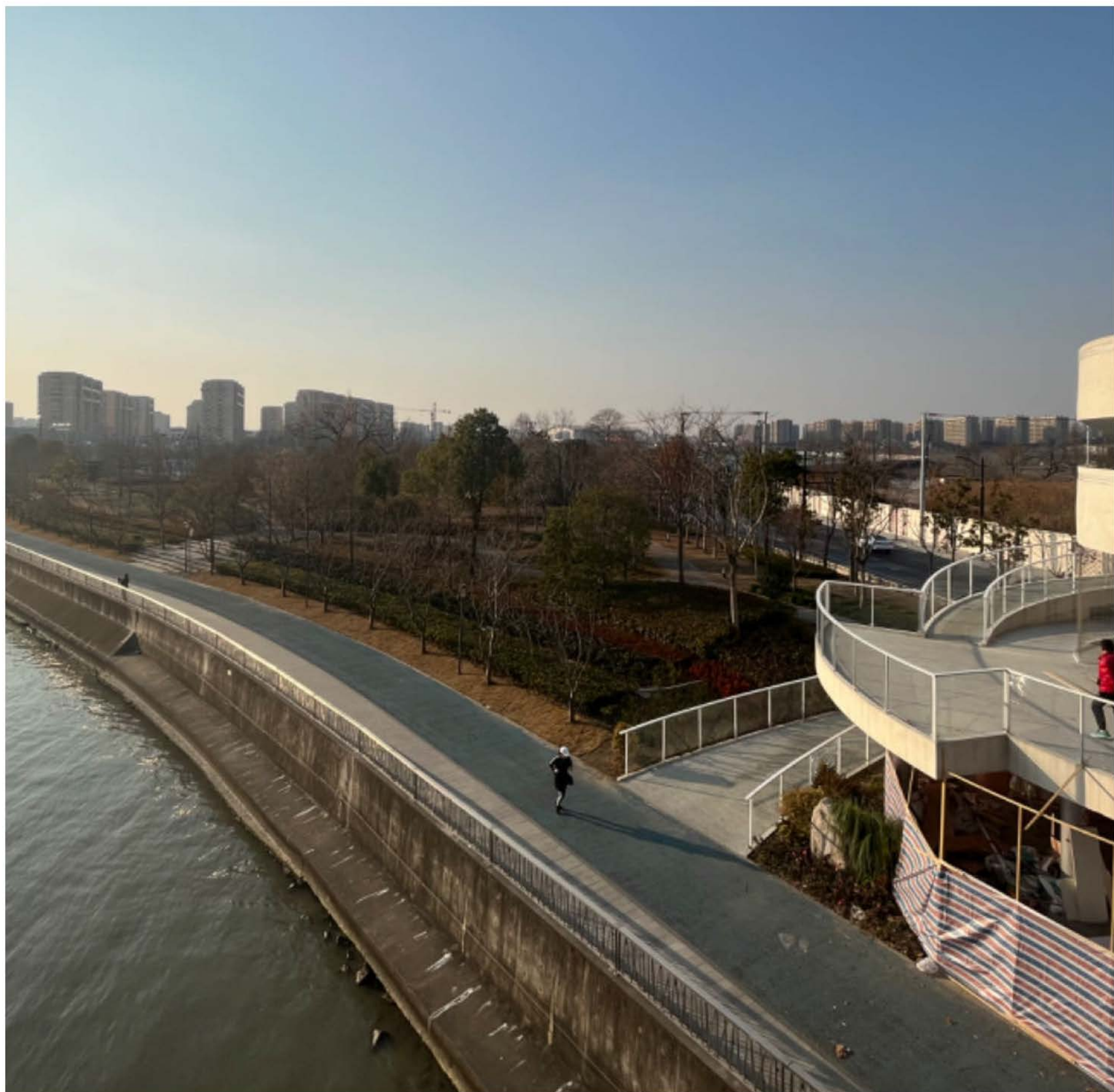
苏河岸线公园现状
