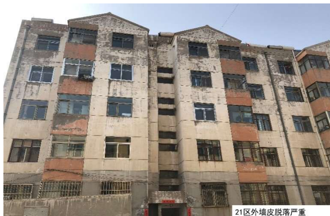
21区外墙皮脱落严重
